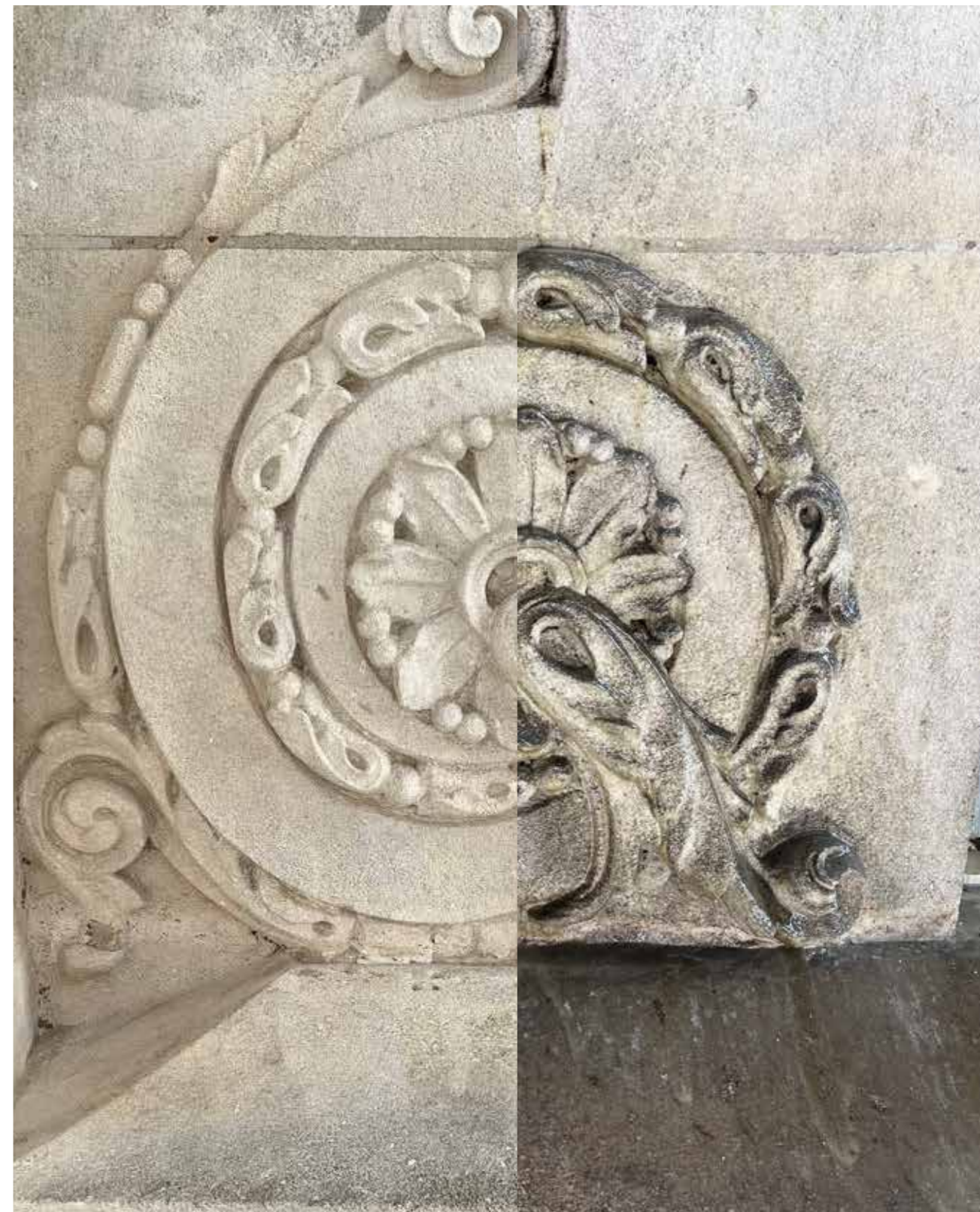
Modénature en pierre du CCI de Toulouse, nettoyée sans abrasion avec le SOLUROC de la gamme EDIFICA
